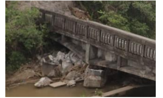
写真-2 平田・小柳線 田中橋
