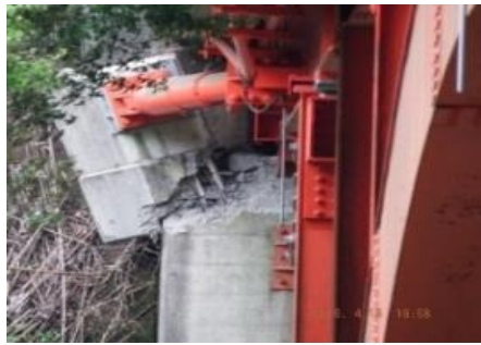
写真-2 ダンパー取付部の損傷 ( みなみあて 国道325号・南阿蘇橋)
