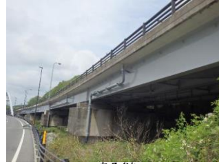
写真-4 阿蘇口大橋 (国道57号)
