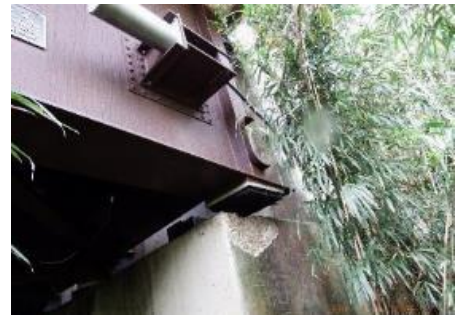
写真-1 曲線橋のゴム支承等の破断 ( おおきりした 県道熊本高森線・大切畑大橋)
