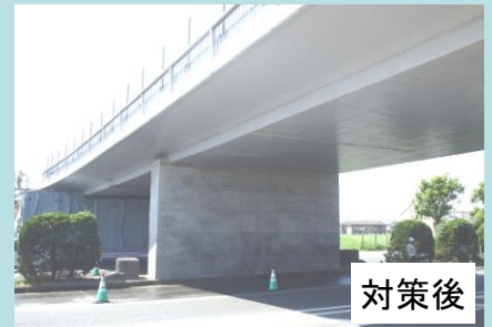
写真-1 完全自立構造の施工例
