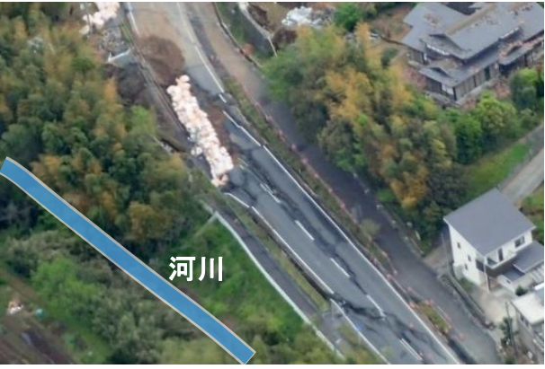
写真-1 国道443号の盛土崩壊全景
