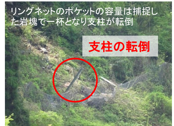
写真-2 支柱の転倒状況
