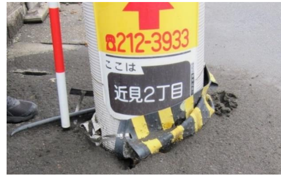
写真-3 液状化による電柱の沈下
