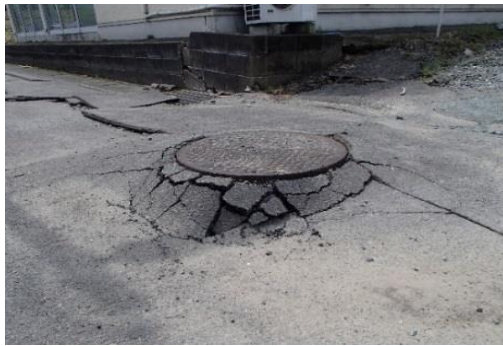
写真-1 マンホールの浮き上がり及び周辺地盤の沈下
