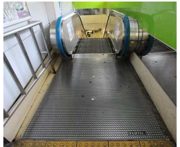
写真1 事故発生場所
