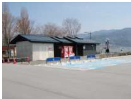
【防災ヘリポート広場 (燃料庫、トイレ、防災倉庫)】
