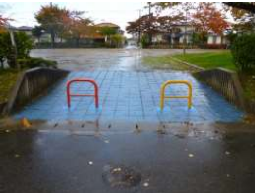
【以前の出入口は平板ブロック構造 (車両に耐えられない)】
