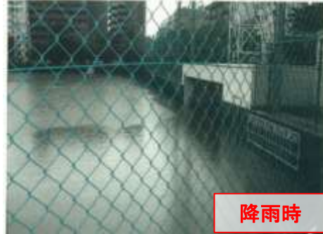
【野球場を約1.8m掘り下げて整備した調整池に雨水貯留】
