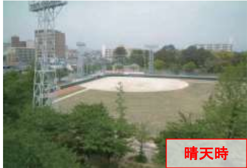
【野球場を約1.8m掘り下げて整備した調整池に雨水貯留】
