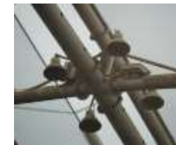
【照明施設再整備前 (メタルハライドランプ1000W)】
