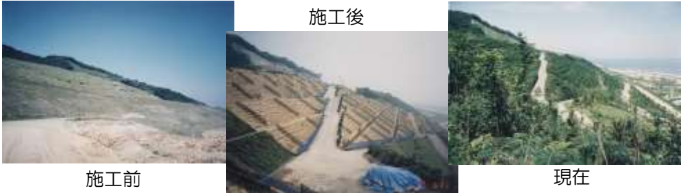
【施工後3年で周辺地域に近い林相が復活】
