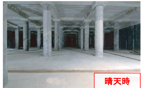
【公園の地下に整備した調整池に雨水貯留】
