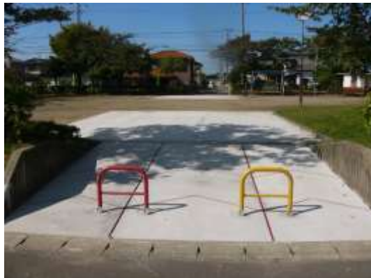
【車両にも耐えるコンクリート版構造に強化 (公園施設の破損防止)】
