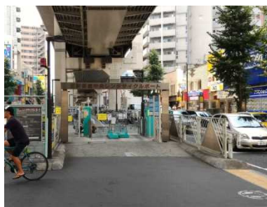
道路(路上以外)に設置 陸橋下のスペース (世田谷区)
