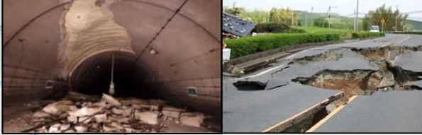
県道 熊本高森線 阿蘇郡西原村～南阿蘇村（俵山トンネル等）覆工崩落、路面陥没
