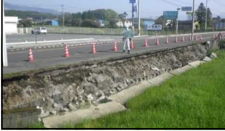
国道3号 熊本市北区清水町 松崎跨線橋 路面沈下
