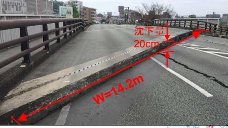
国道3号 熊本市北区清水町 松崎跨線橋 路面沈下
