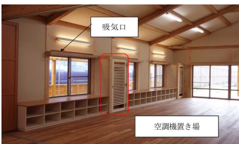
第 5 章第 2 項 建築意匠に応じた設備設計 (エコブリッジ志段味の集会場 名古屋市)
