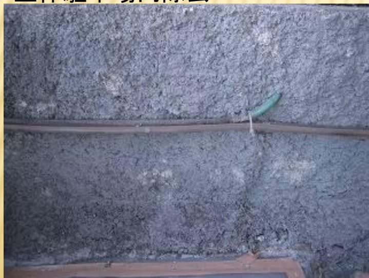
設備機械室内除去
