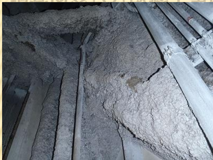
立体駐車場内除去
