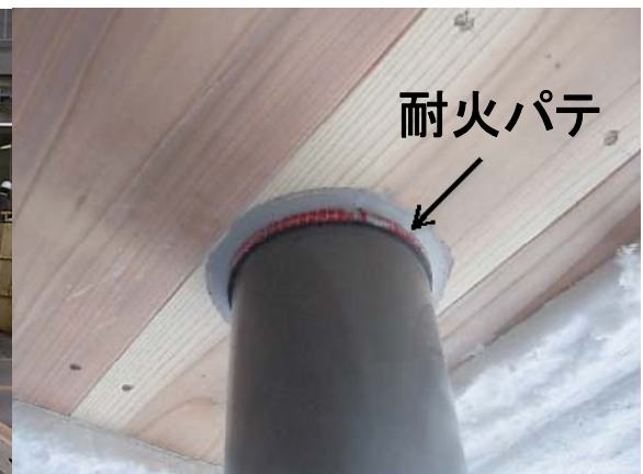
③配管貫通処理の一例
