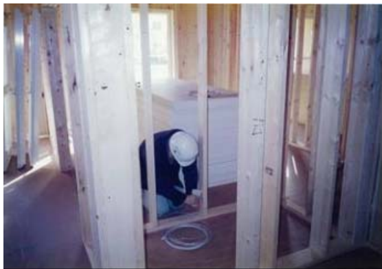
作業1 実験棟熱電対取付け例
