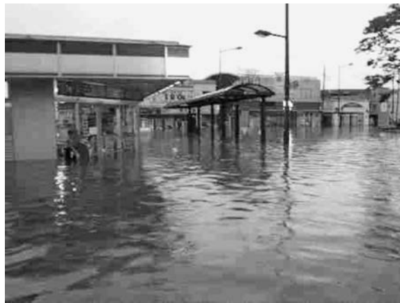
図表1-2-3 平成27年9月の浸水被害 (埼玉県越谷市)
