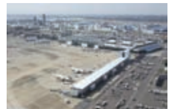
成田国際空港第3ターミナル （提供：成田国際空港株式会社）
