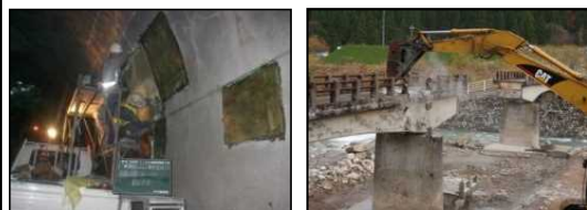
トンネルの修繕
