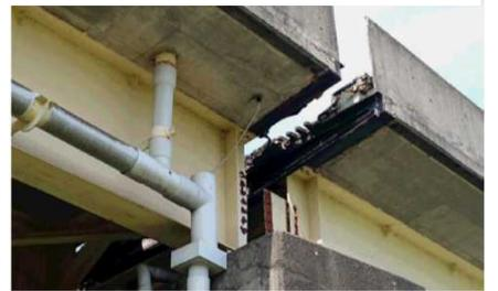
桁のずれ(開き 約30~40cm)
