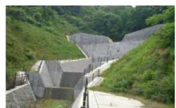
砂防堰堤の整備
