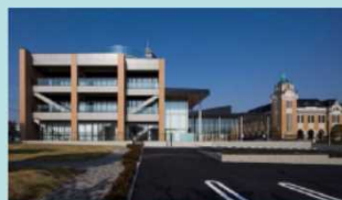
地中熱式空調設備を導入した「中央公民館」
