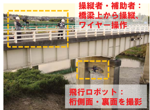
現場検証の様子
