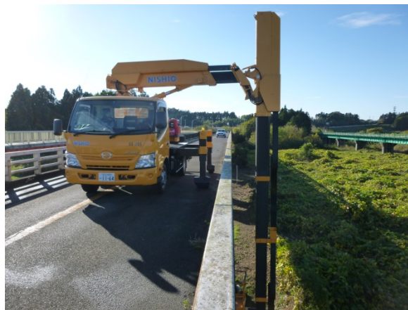
従来手法による点検状況（橋梁点検車を使用）
