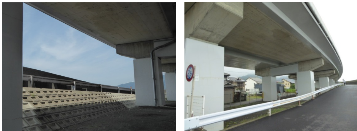
蒲原高架橋検証地状況
