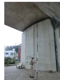
支承部の点検
