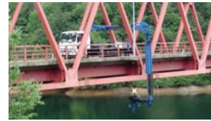
橋梁下面点検
