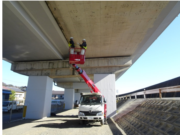
従来手法による点検状況（高所作業車を使用）
