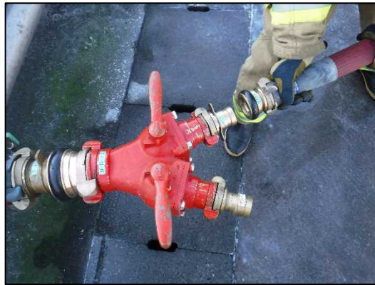
Step2 Yゲートへの40mm消火ホースの取付
