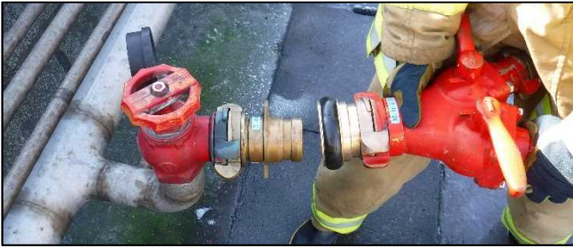
Step1 機動消防用具の接続。水量等確認
