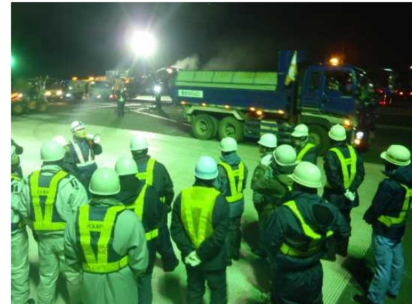
【工事見学実施状況】
