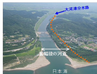
図 21 浸水被害軽減に向けた河川改修(大河津分水路の拡幅)
