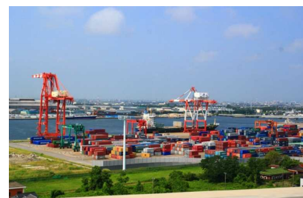
図 24 国際物流ターミナル整備(伏木富山港)
