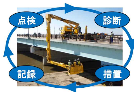
図 28 メンテナンスサイクルの構築
