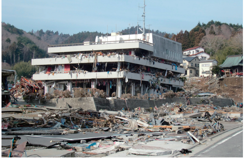
被災した女川町役場。津波は3階部を呑み込み屋上にも迫った。当時在所した方や近所の方たちは、屋上のさらに上、塔屋部に避難し何とか難を逃れたという。(写真提供：女川町)
