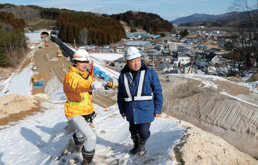
佐々木（左）が担当する工事現場のすぐ脇には住宅地が広がる。トンネル掘削用の火薬を仕掛けるときは事前に連絡するとともに、定期的に住民宅を訪れて工事への要望を聞く。
