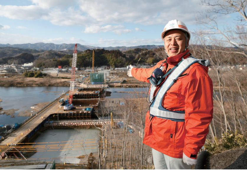
閉伊川に架かる橋梁の工事現場。この橋梁は三陸沿岸道路の一部である「宮古老道路」の橋で、河川・道路・鉄道を超え、丘陵部を切り開いて整備する道路とつなげていく。工事を一望できるこの高台は庄司のお気に入りスポットだ。
