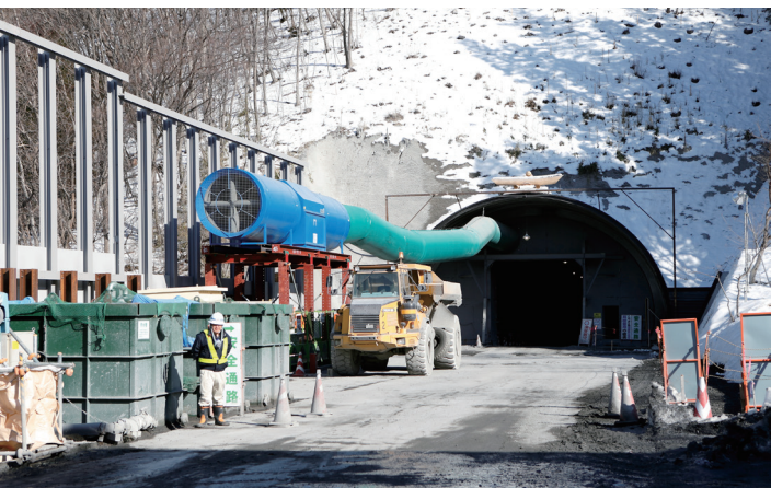
掘削現場では多量のちりが舞い、数十メートル先がかすむ。トンネル入口に構えた送風管は、1分間に2,000㎡の空気を処理できる空気清浄機の役割を持つ。
