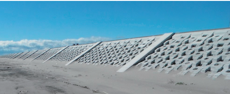
多重防御の第一線である完成した海岸堤防(仙台湾岸/深沼地区)。巨大津波が越流しても粘り強く効果を発揮する構造となっている。
