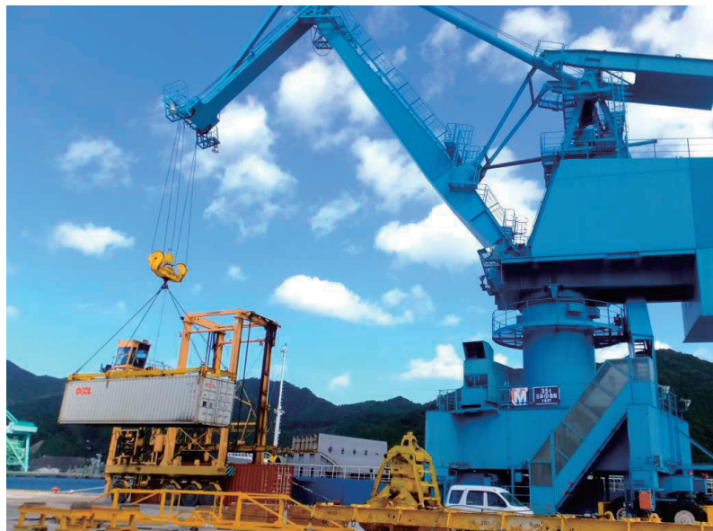
岩手県釜石港では、港湾と道路の整備によって物流が活発になり、平成27年のコンテナ取扱量が県内の過去最高記録を更新した。
