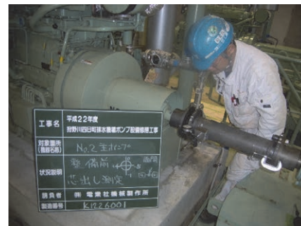
写真3 芯出し計測状況
