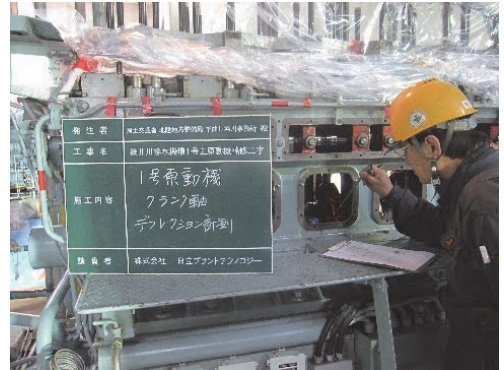
写真2 デフレクション計測状況
