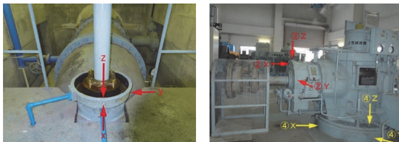
図 1 振動の測定位置
