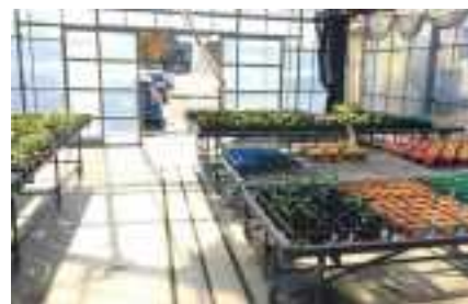
屋内に設けられたあぐりん村ふれあい農園 （広くとられた作業台の通路幅、床面コンクリートに水抜き用の切込みを入れてある）
