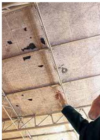
2012.11.25 輪島市上野台中体育館 天井崩落
