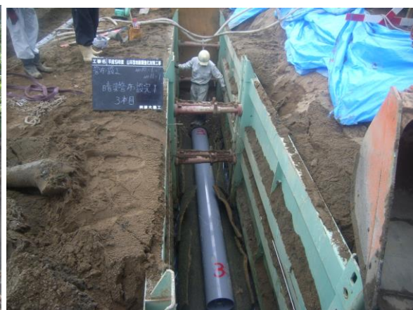
写真-6 暗渠排水管の布設状況
