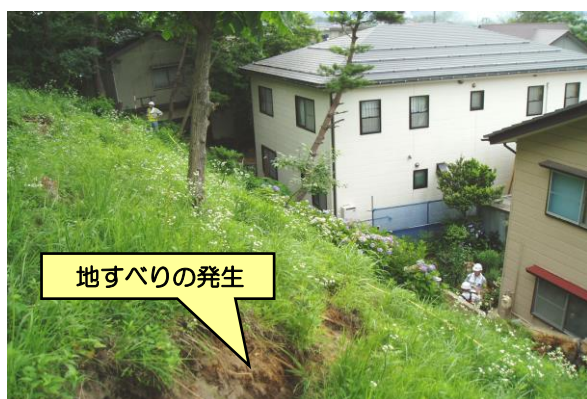
写真-1 砂山の宅地へ地すべり
