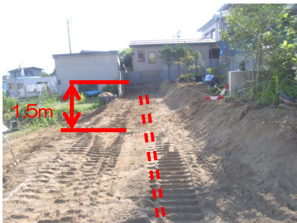
写真-5 暗渠管布設位置
