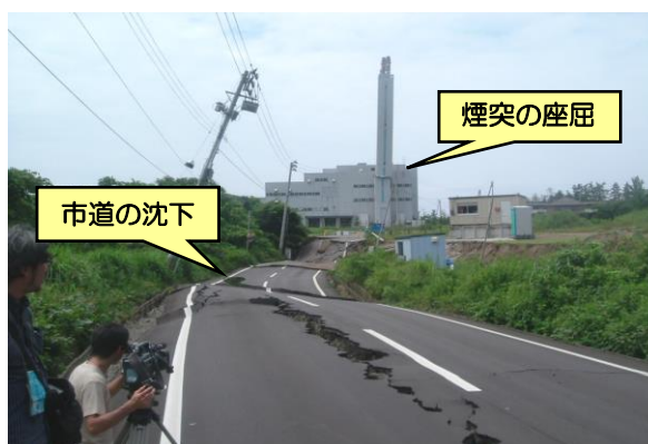
写真-2 液状化による柏崎市道の地すべり
