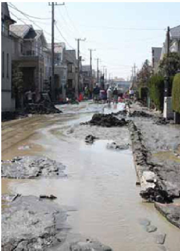
写真 1-1 住宅地の噴砂の状況
