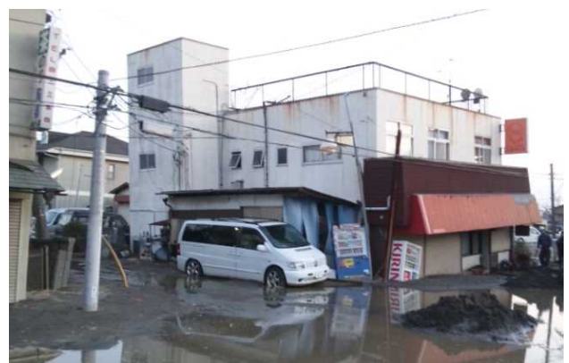
写真 1-3 建物の傾斜被害
