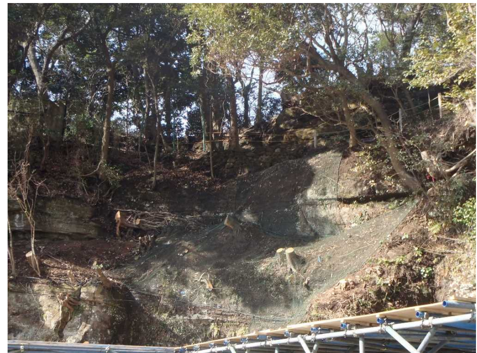
崖面の崩落防止(樹脂繊維ネット)
