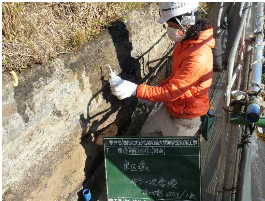
崖面での岩質強化処理 (基質強化剤の含浸処理)
