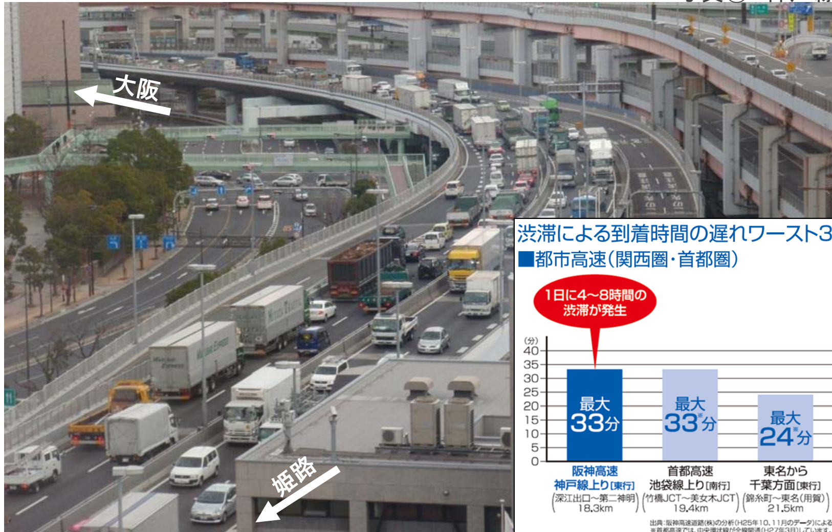
阪神高速神戸線 京橋ランプ付近
