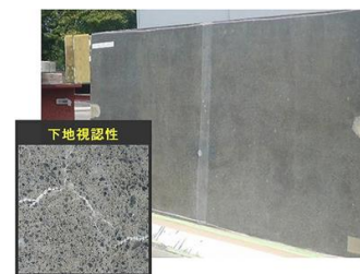
繊維シートと接着剤による剥落防止技術
