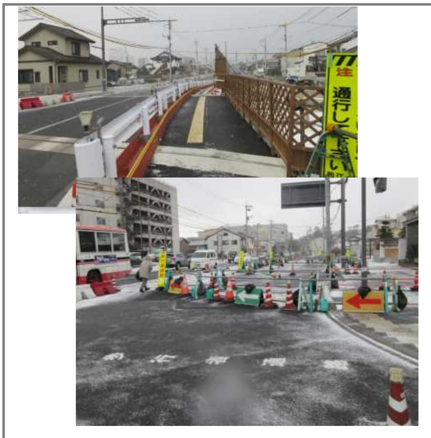
<歩道の拡張工事を実施中>
