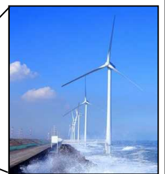
洋上風力発電施設
