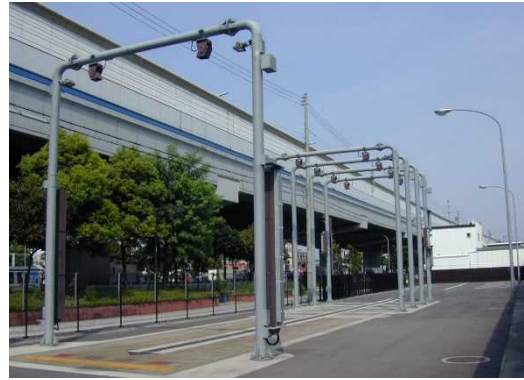
車両重量計設備の事例
