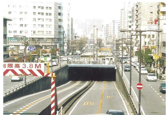
道路排水設備の事例
