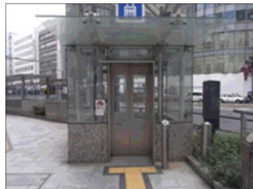
道路用昇降設備の事例
