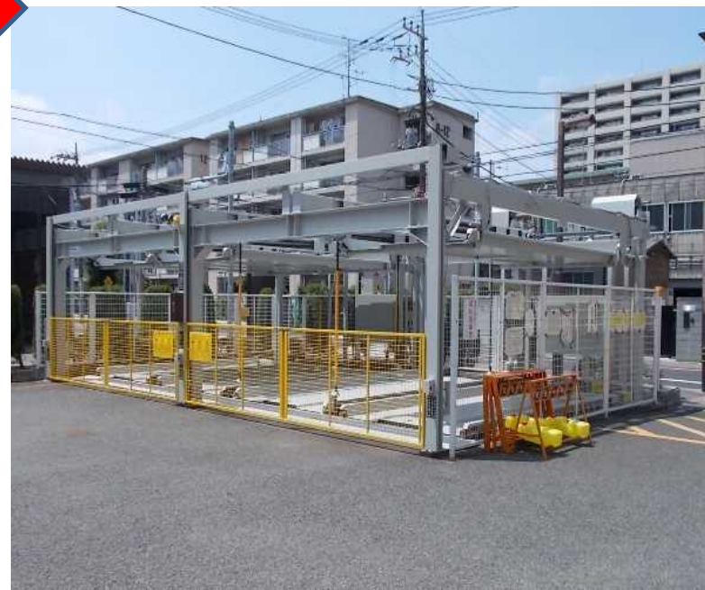
前面ゲート設置後
