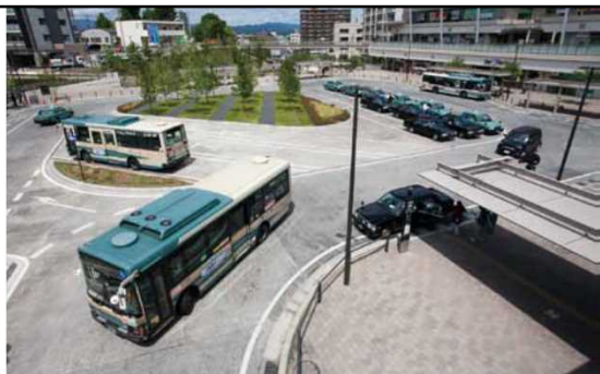
整備後の駅前広場の状況
