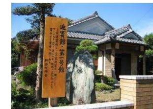
改修した古民家 (出典) やねだんwebサイト
