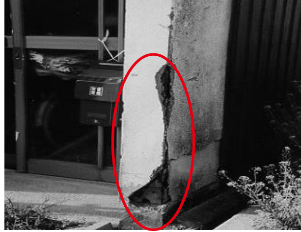
(例4) 土台が著しく腐朽している。(例5) 外壁が破損している。
