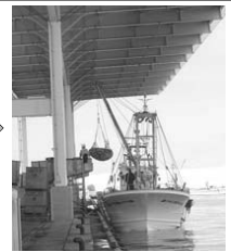
屋根付き岸壁の整備
