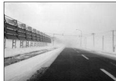
防雪柵の設置
