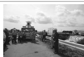
緊急排水の作業状況を関係者に報告
