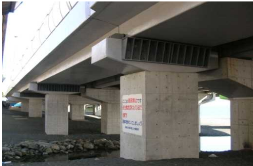
<橋梁の耐震補強>
