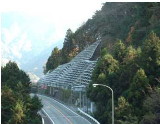
< 斜面崩落防止対策 >
