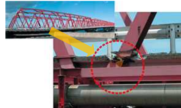
鋼材破断の損傷事例(国道23号木曾川大橋)
