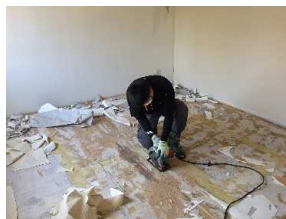
CF・クロス撤去 汚染部解体
