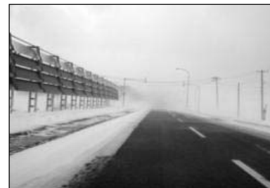
防雪柵の設置
