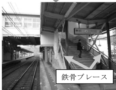
【橋上駅の補強】
