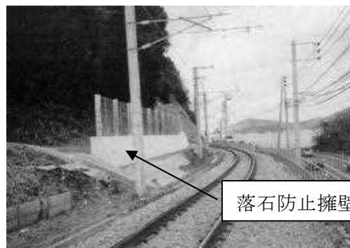
【落石防止擁壁の一例】
