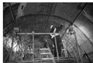
繊維シート貼付
