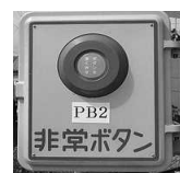
(非常押しボタンの例)
