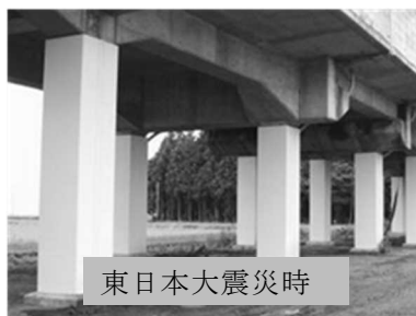
【高架橋の補強】
