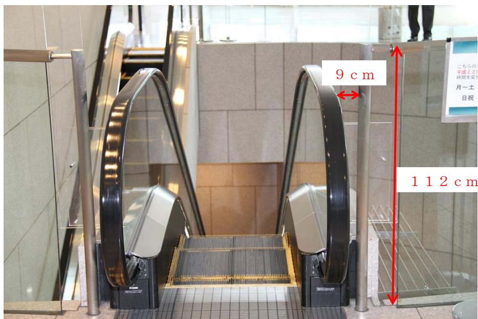
写真2. 吹抜けに面する部分の安全柵
