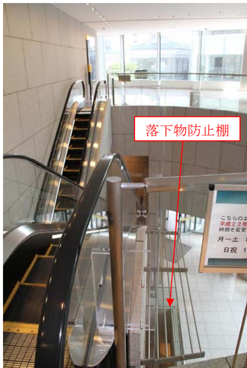
写真3. 落下物防止柵
