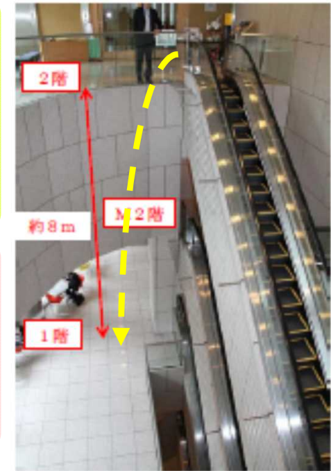
写真1. 事故が発生した吹抜け部分
