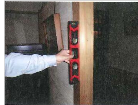
水平器による柱の傾きの計測
