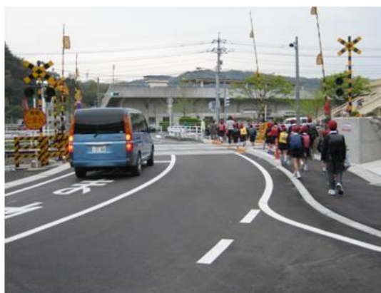
<歩道拡幅(島根県浜田市)>
