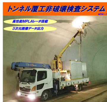
トンネル覆工内部調査 （レーダ計測）
